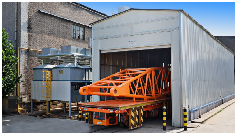
新建先进的大型喷漆房
