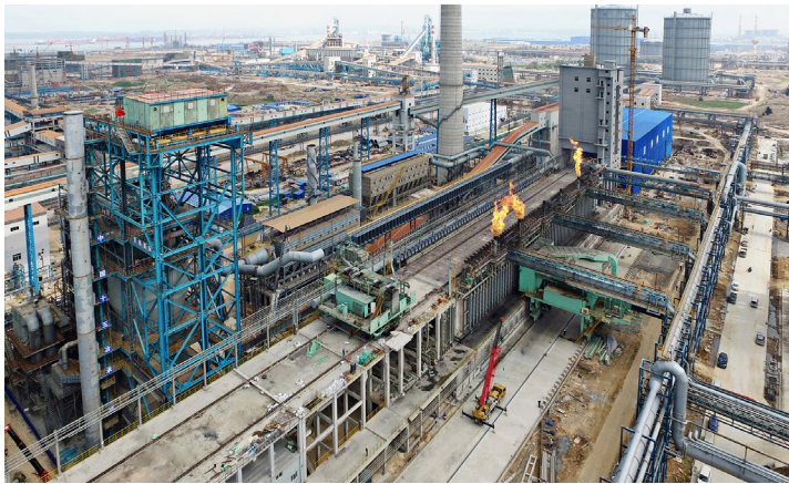
太重研制的国内首套智能化7.5米顶装焦炉成套设备在用户现场试车
